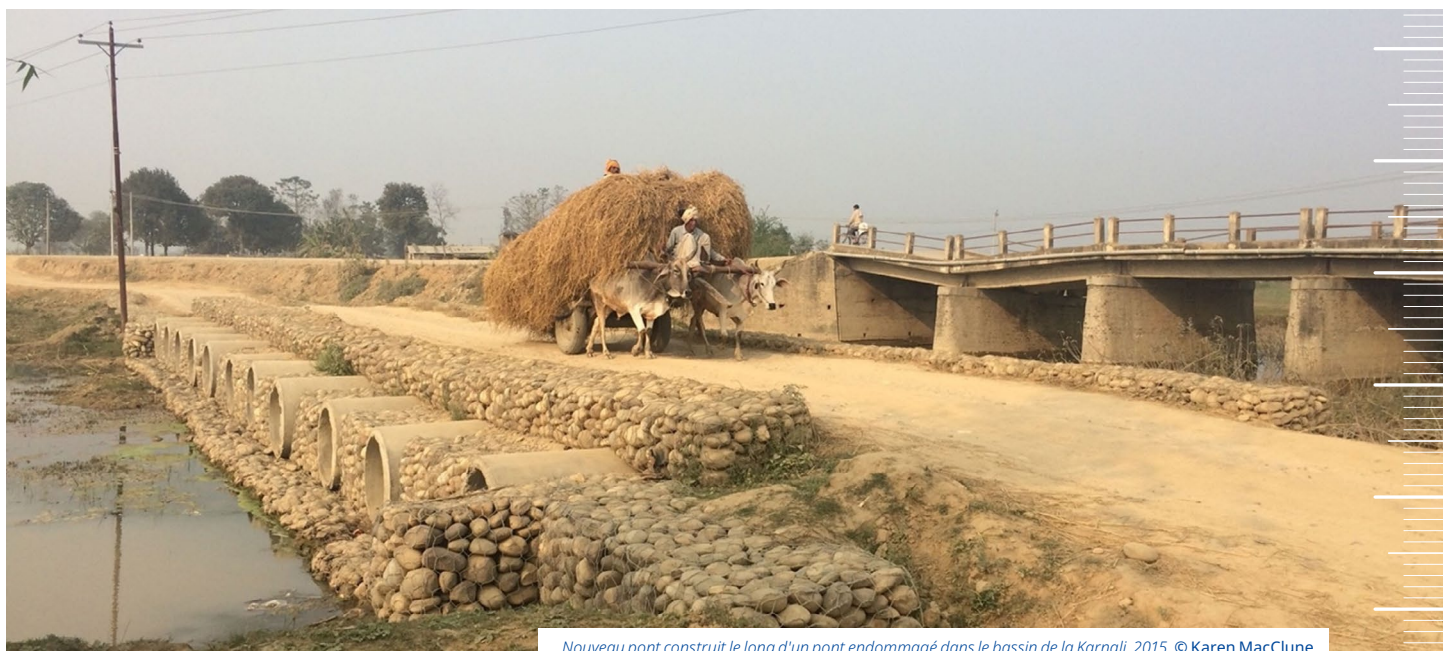
Nouveau pont construit le long d'un pont endommagé dans le bassin de la Karnali, 2015. © Karen MacClune
